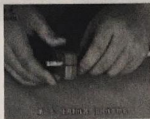
图4-7 剥除护套
